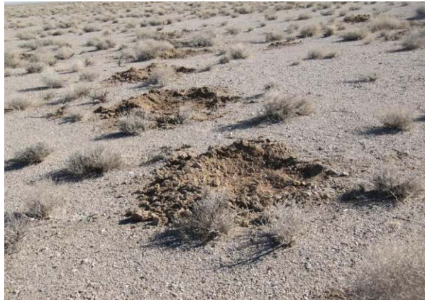
شکل ۴- احداث هلالی آبگیر در منطقه اجرای طرح
