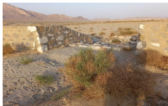
شکل ۳- کاهش ارتفاع دروازه‌های پخش Figure 3- Height reduction of spreading gates
