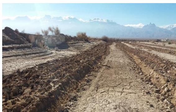
شکل ۵- اختلاط رسوبات همراه سیل با شن بستر عرصه پخش با شخم سطحی
